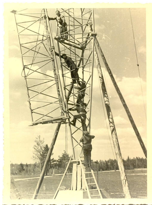
5.att. Metāla masta kārtējā posma montēšana
