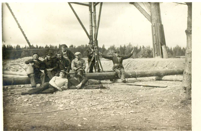
1.att. Koka mastu celāji
